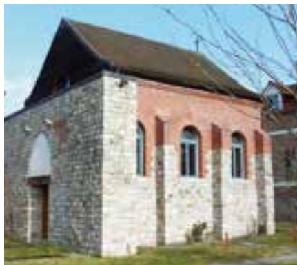
Chapelle du Prieuré © Ville de W. Hamage
